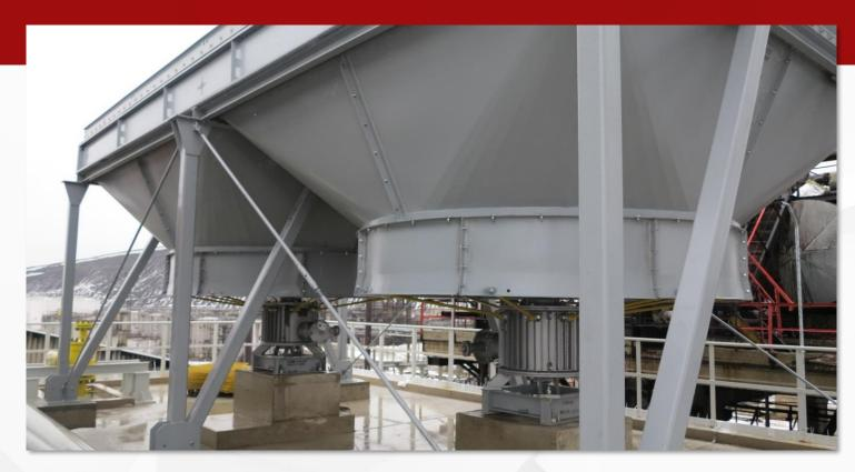
Нагнетательного типа. Компоновка 2АВГ.
